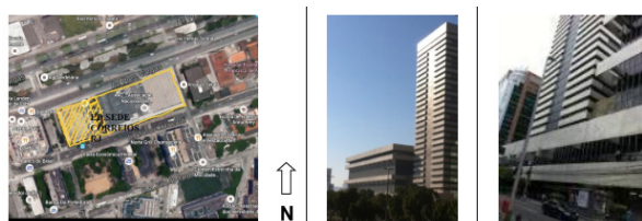
Figura 3 — Localização e fachadas do Ed. Sede/ RJ
